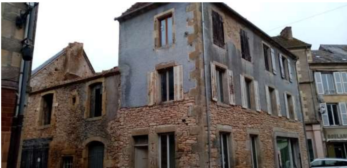
25 rue du Commerce (A 665) – vue depuis la rue du Commerce
