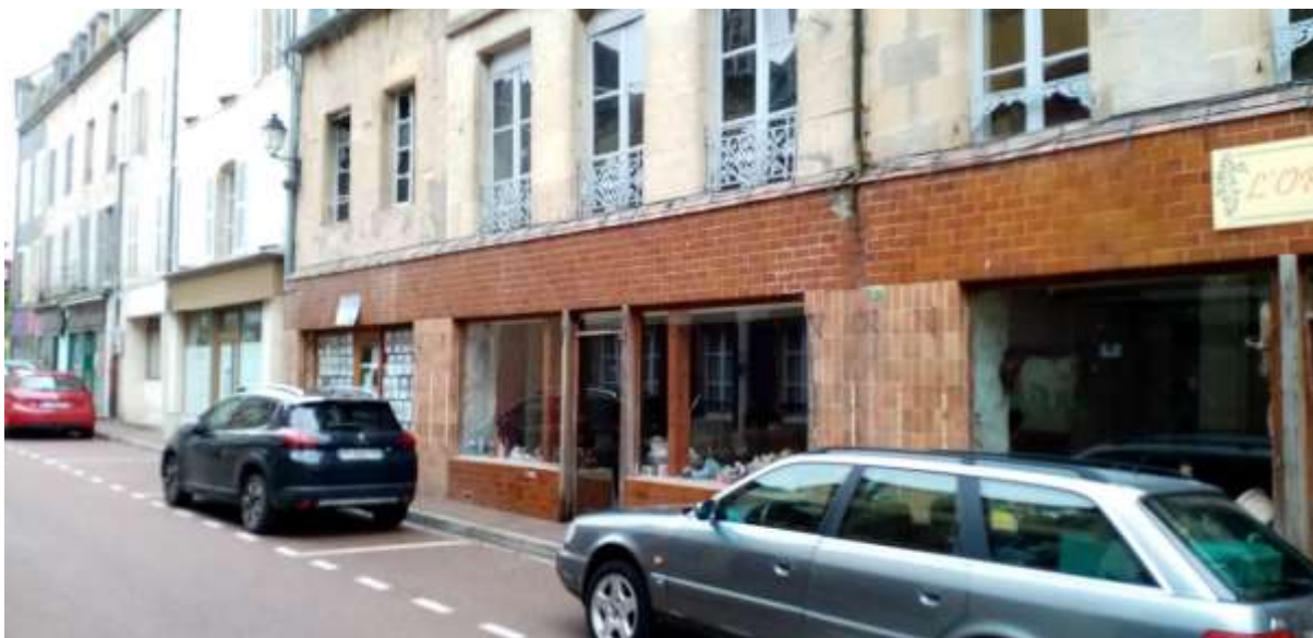
Immeuble « orangerie » - vue depuis la rue du commerce (A 663 et A 664)
