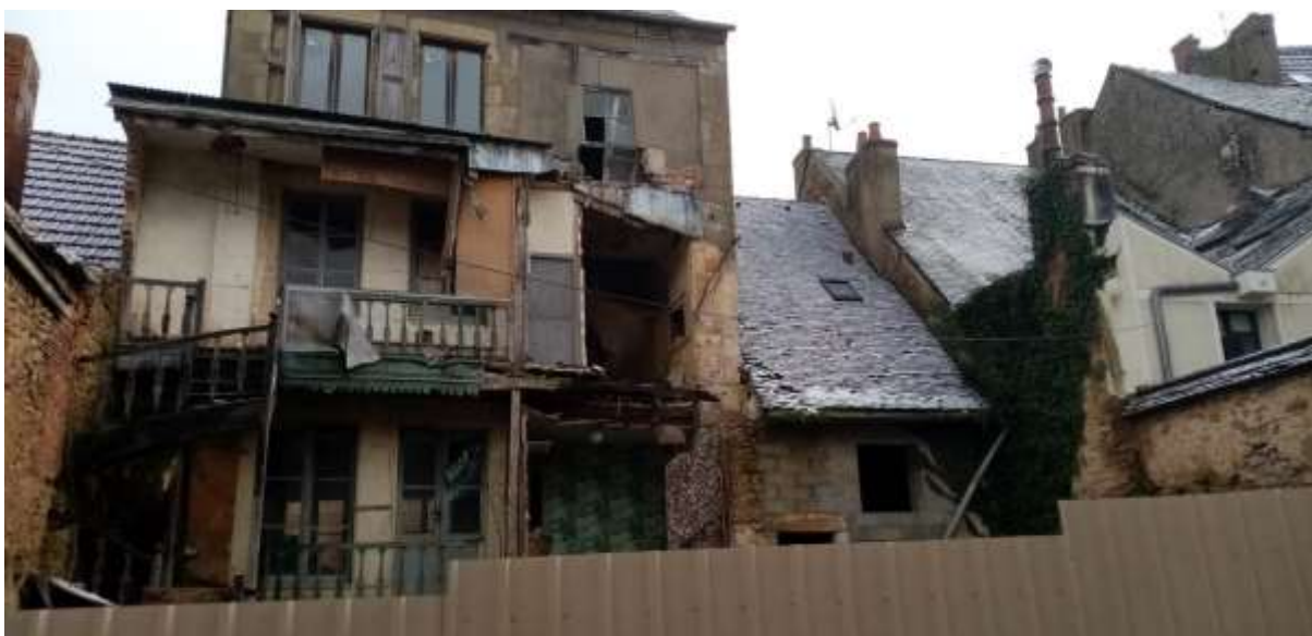
Immeuble « orangerie » - vue depuis la rue Jules Renard (A 663 et A 664)
